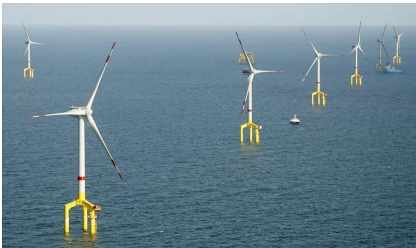
Abbildung 2: Windenergieanlagen Typ BARD 5.0 im Windpark BARD Offshore 1
