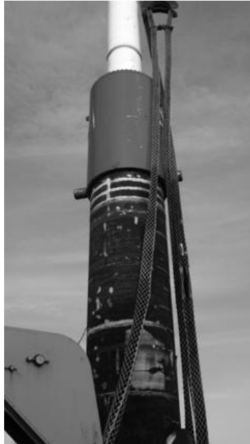
Abbildung 5: Monitoring der Rammung, Monopile für Messmast im OWP Nordsee Ost
