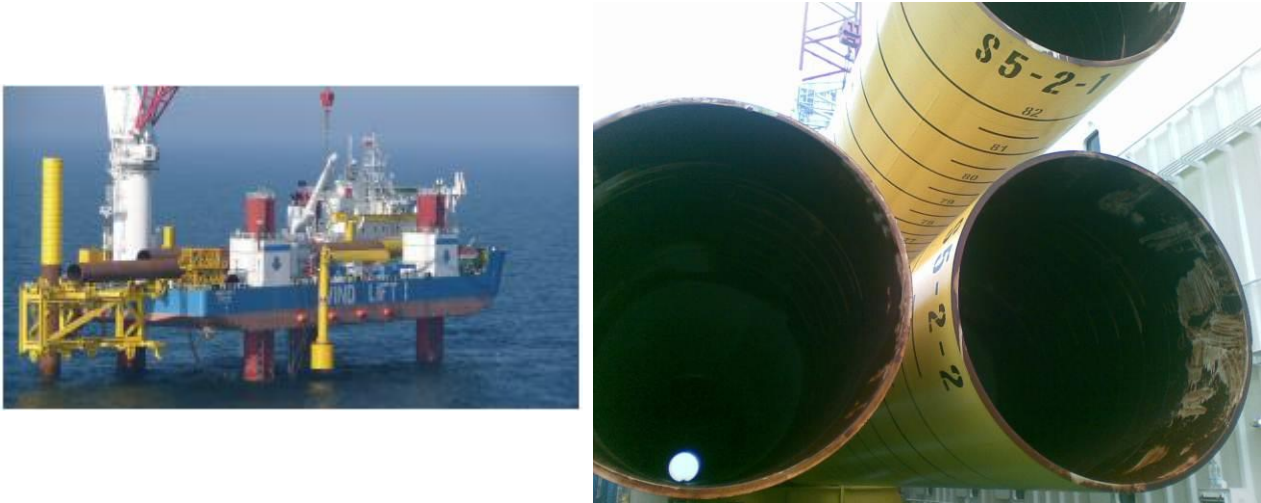
Abbildung 3: Gründungspfähle einer WEA (rechts) auf der Wind Lift I (links) unmittelbar vor der Rammung
